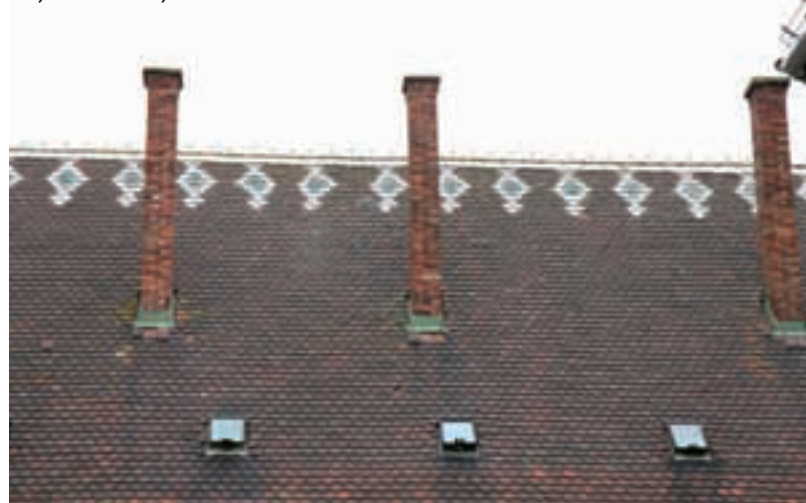
Krov ugrožavaju »rascvjetali« dimnjaci
