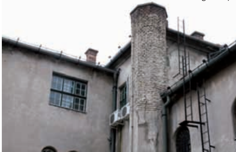
Krov ugrožavaju »rascvjetali« dimnjaci
