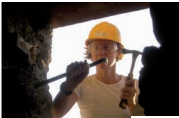
Probijanje otvora i umetanje grede
