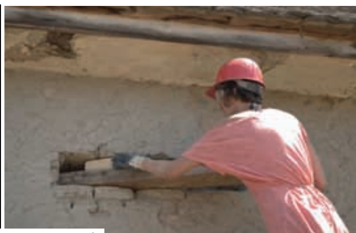
Probijanje otvora i umetanje grede
